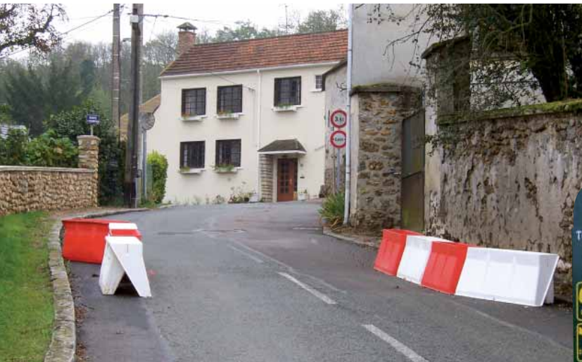
Aménagement provisoire d'une chicane
